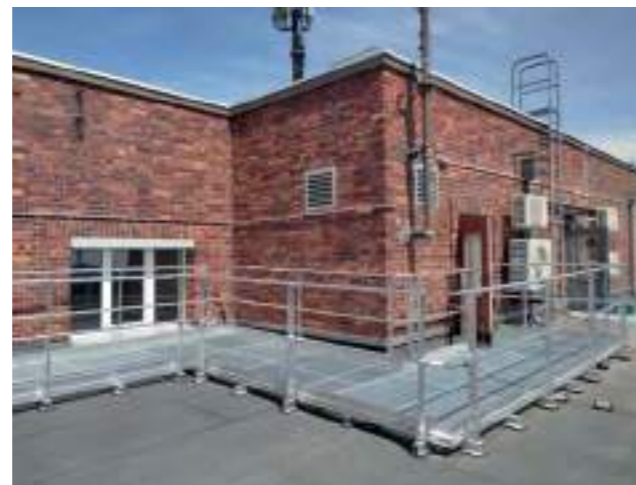
Durchdringungsfreie selbsttragende Konstruktion
